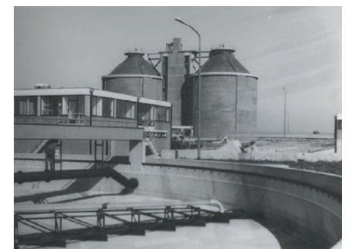
Rioolzuiveringsinstallatie kort na oplevering in 1967
